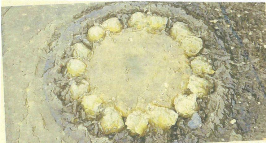
Bild: Schmutzwasseraustritt aus einem Schachtdeckel
